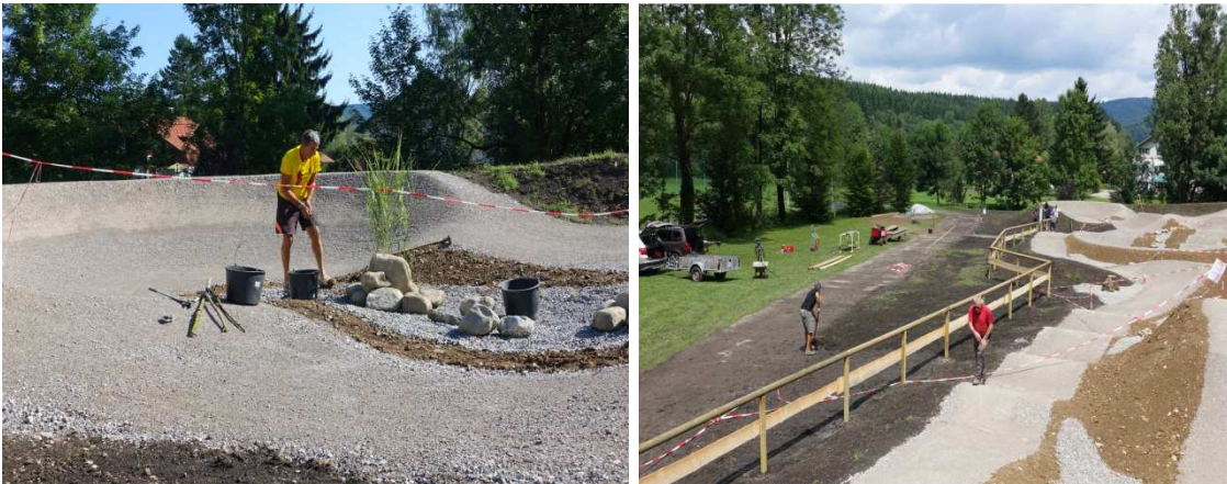
Bild 3 und 4 Ausführung während der Bauphase
