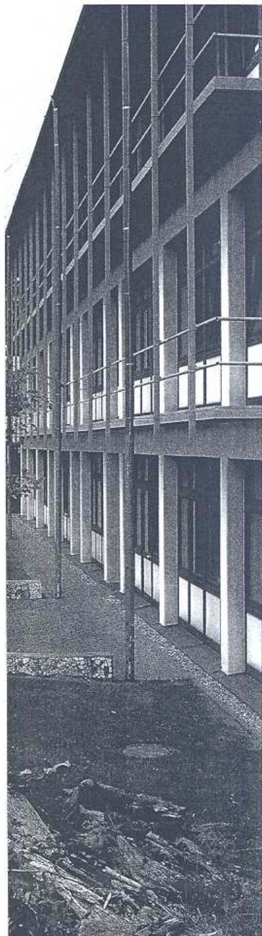
Für 10 Millionen Euro bestens saniert und ausgestattet für einen Schulbetrieb bis zur 10. Jahrgangsstufe.
